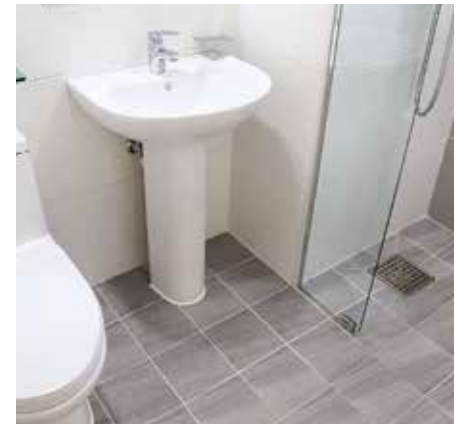
숙소 2개 화장실 내 샤워실 설치
